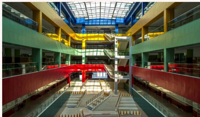
风向为南风 and 东南风，接近于南北朝向，最大限度地保证了建筑立面朝向夏季及过渡季的主导风向。建筑立面的风口呈对称且均匀分布，有利于形成“穿堂风”。建筑南北向进深较小，每个功能空间都有可开启通风面积，有利于气流短时间内穿过建筑，增强自然通风效果。儿童楼内部设置庭院，由地下连通至顶层，顶部天窗可开启，可以利用热压将促进室内自然通风。
